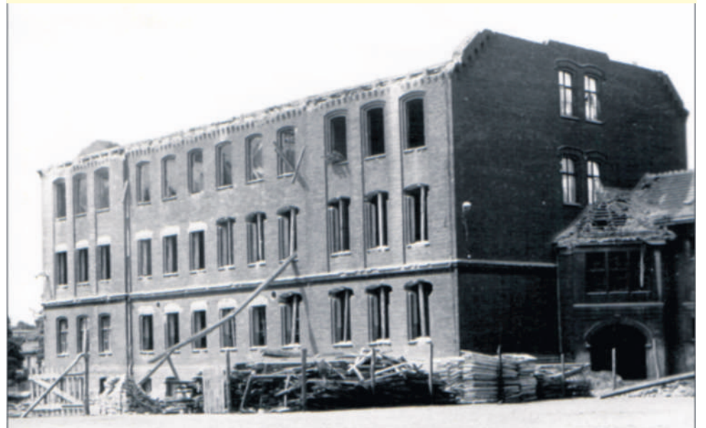
Rok 1975. W czasie przebudowy szkoły usunięto dwuspadowy dach kryty dachówką. Otwory okienne zmniejszono nadając im nowoczesny wygląd (ASP 2, Ch, Nr 6, l. 1982-85)
